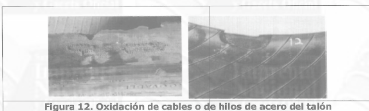
Figura 12. Oxidación de cables o de hilos de acero del talón
